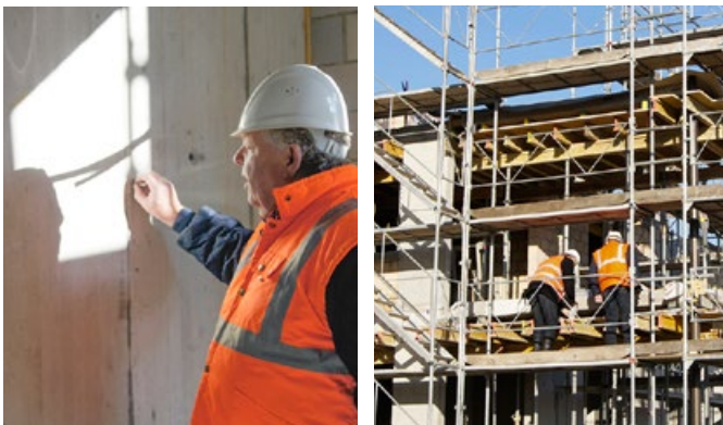
Roland Wolfseher setzt verschiedene Instrumente ein: Links tastet er mit einem Magnet die Wände ab, rechts führt er mit Frank Domschat den Sprüh-Test durch.
