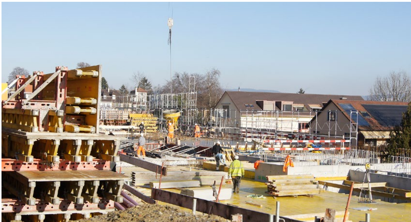
Auf der Baustelle Entlisberg 2 wurde ein grosser Teil des Aushubmaterials vor Ort zwischengelagert und wiederverwendet, um die Lastwagenfahrten durchs Quartier zu reduzieren.
